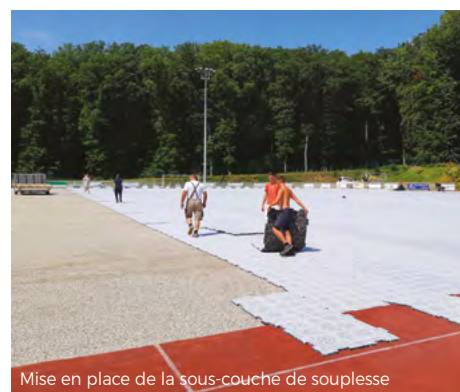
Mise en place de la sous-couche de souplesse
