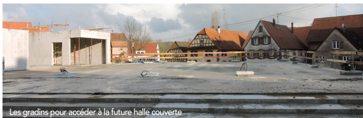
Les gradins pour accéder à la future halle couverte
