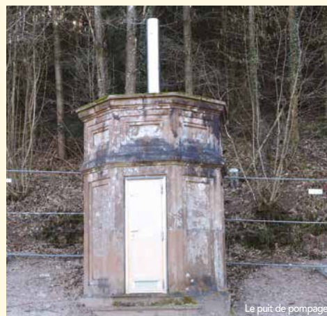
Le puit de pompage
