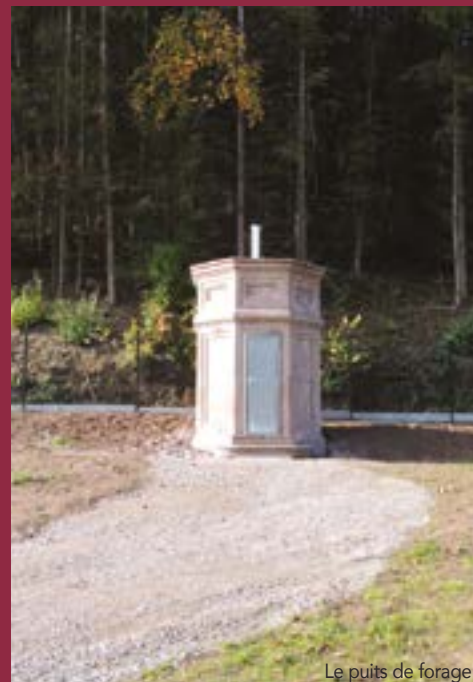
Le puits de forage
