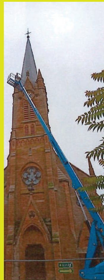
Intervention réalisée à la nacelle avec technicien cordiste.
